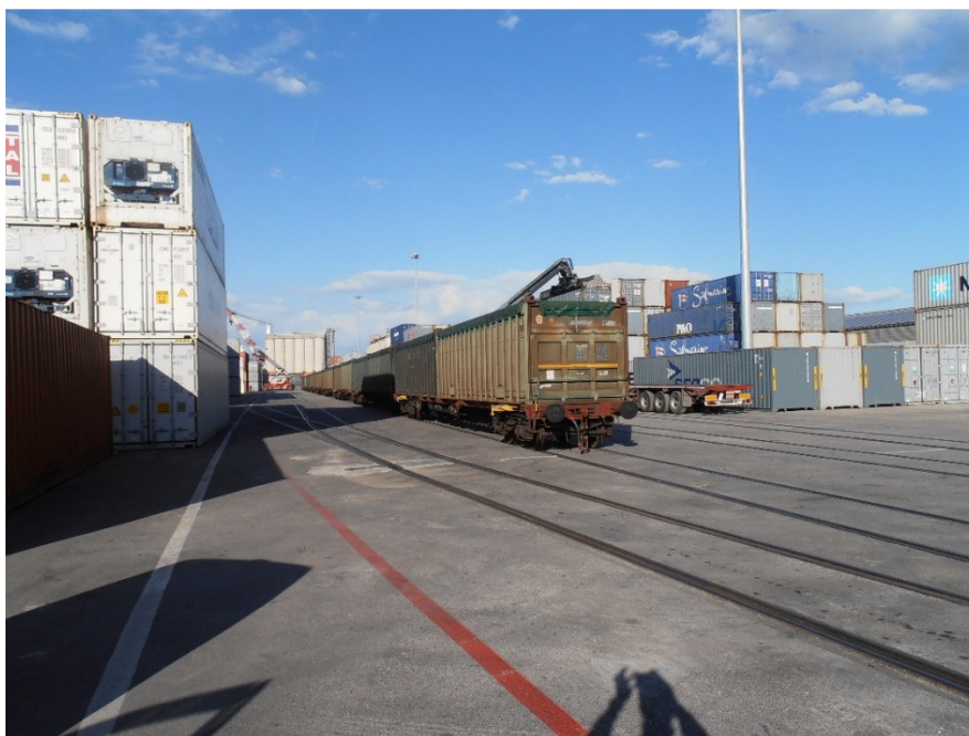
Nuovo raccordo ferroviario – zona del fascio di appoggio nel piazzale portuale della darsena Marche
