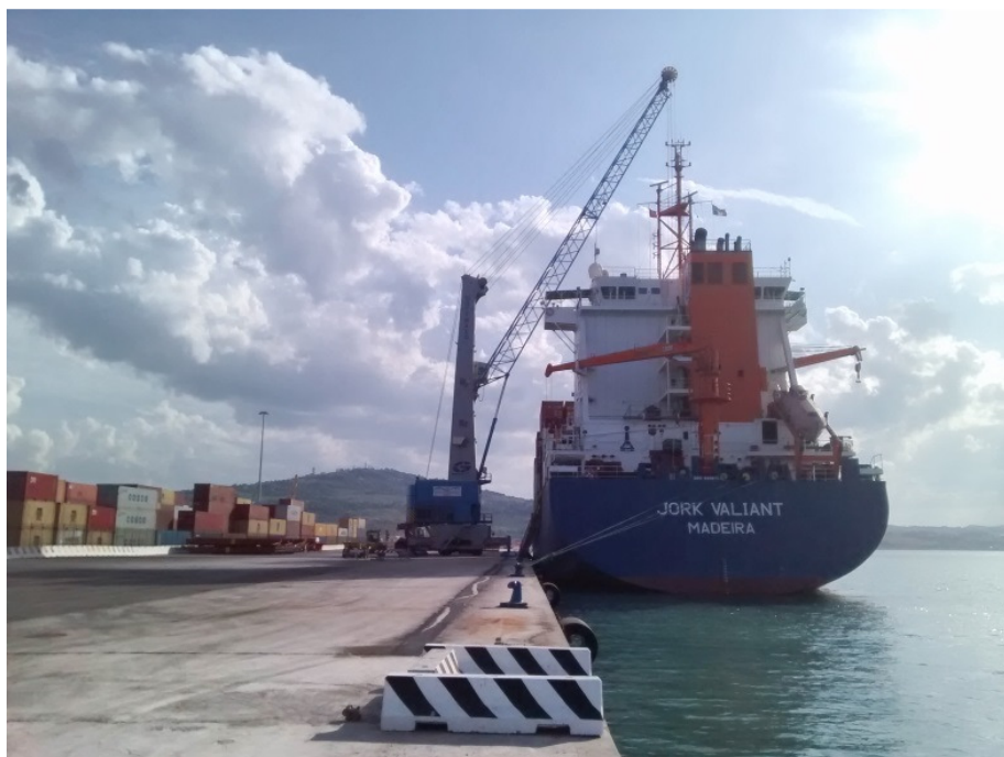
Nuova banchina d'ormeggio n. 26
