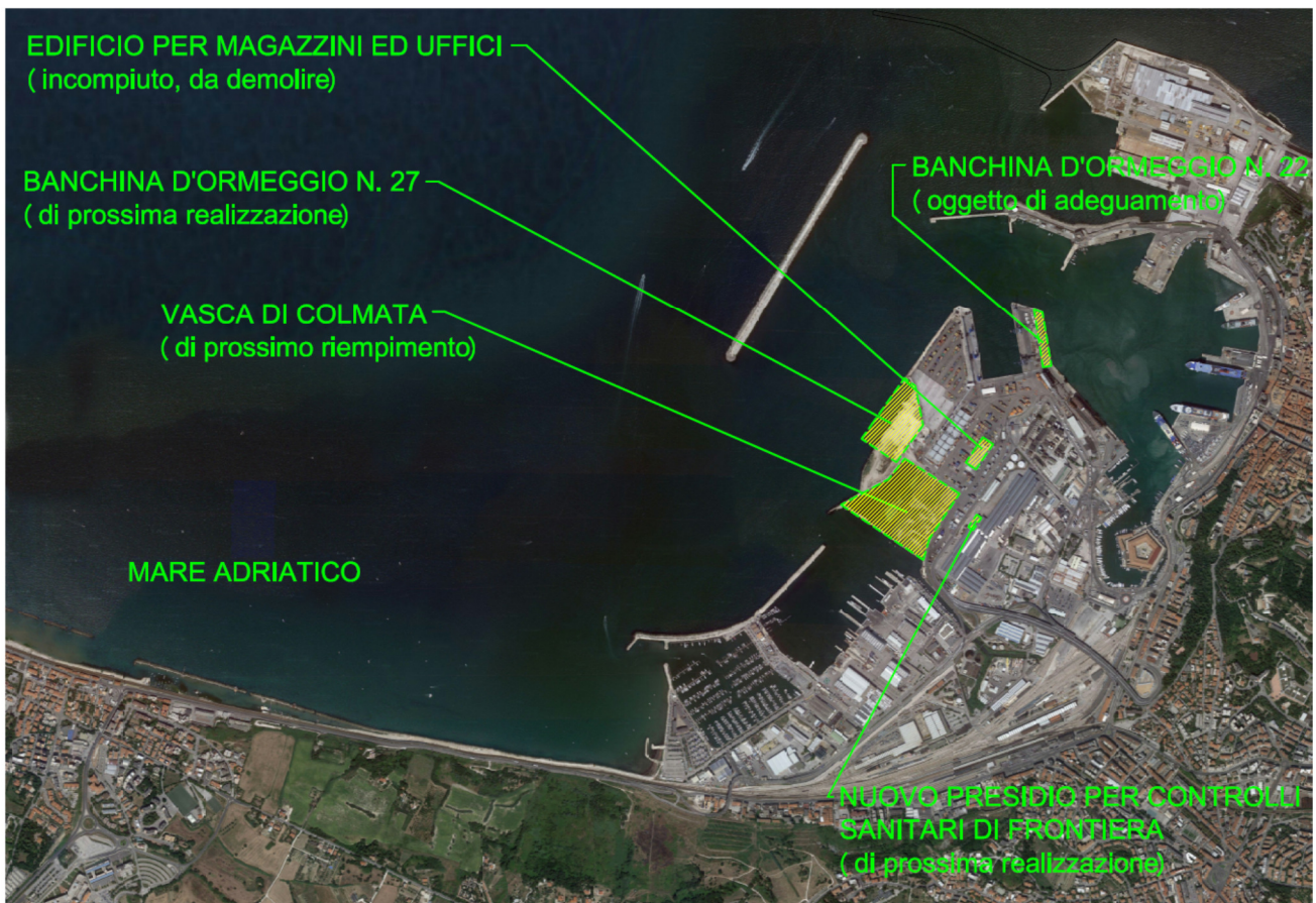
Opere infrastrutturali in corso di realizzazione nella zona della darsena Marche – vista aerea
