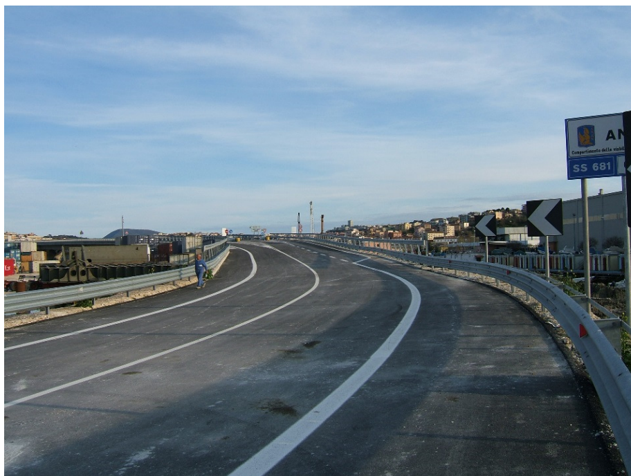
Nuovo svincolo stradale di collegamento con la darsena Marche
